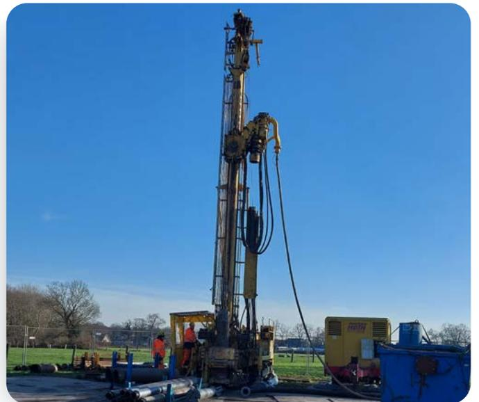
Der wasserbehördlich genehmigte Pumpversuch soll mit einer Menge von 30 m<sup>3</sup>/h im Dauerbetrieb für ca. 3 Jahre durchgeführt werden. Das Ziel ist die Fördermenge von 240.000 m<sup>3</sup>/a für den Brunnen VB 4.3 zukünftig im Rahmen des bestehenden Wasserrechts für das Wasserwerk Hagelshoek zu sichern.
